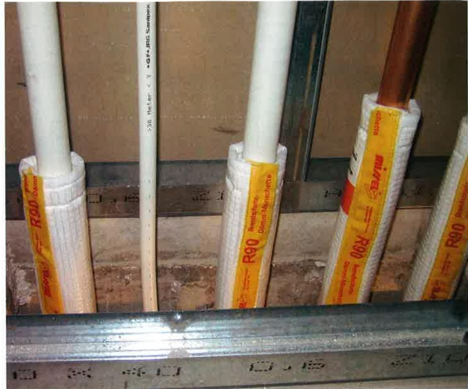
Installation von Schachttyp 1 mit Mistel R90-Rohrabschottungen vor Verguss der Decke.
