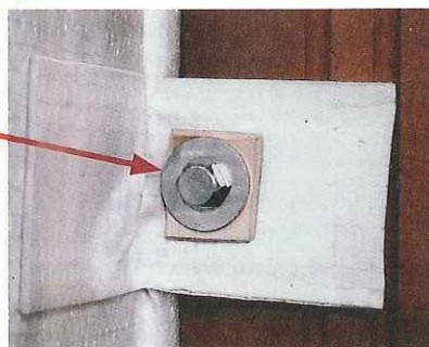
Wandeinbau-Spülkasten, gedämmt mit der Körperschalldämmung MSWC. Neben der Körperschallentkoppelung des Spülkastens muss auch die Befestigung unter Verwendung von Schallschutzprofilen entkoppelt werden.
