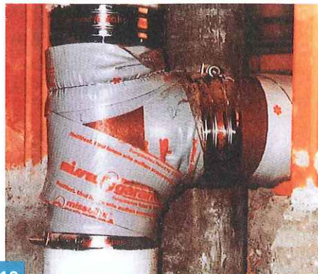
Schallbrücke durch unvollständig ausgeführte Körperschalldämmung.
