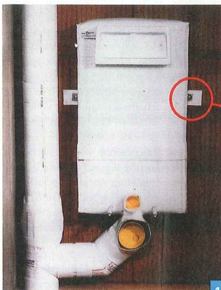
Wandeinbau-Spülkasten, gedämmt mit der Körperschalldämmung MSWC. Neben der Körperschallentkoppelung des Spülkastens muss auch die Befestigung unter Verwendung von Schallschutzprofilen entkoppelt werden.
