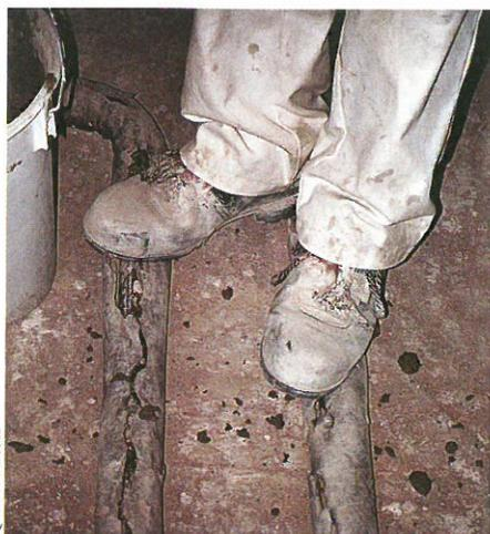
Bild 6: Gefahrenzone Baustelle: Ungedämmte Rohrleitungsabschnitte im Fußboden sollten unbedingt vermieden werden. Ansonsten besteht durch eindringenden Schmutz und Rissbildung die Gefahr von Schallbrücken und Wärmeverlusten.
