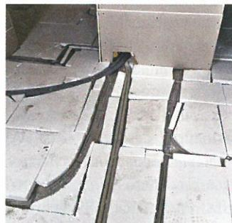
Bilder 3a + b: Dämmplatten ermöglichen eine leichte und saubere Verarbeitung verbunden mit wärmetechnischen Vorteilen. Voraussetzung ist eine fachgerechte Verlegung, sonst ist aufwendige Schnitzarbeit zum Anpassen der Dämmplatten notwendig.
