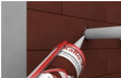
Beidseitige Verfüllung 20 mm tief
