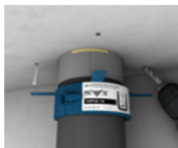
Dübellöcher bohren und Dübel setzen.
