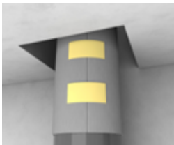
Schaumstreifen mit Klebestreifen um das Rohr befestigen.
