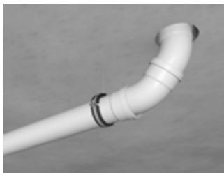
Abwasserleitung, frei verlegt
