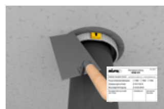
Brandsicherer Verschluss und Kennzeichnung.
