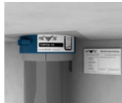
Abschließend Rohrabschottung mit Kennzeichnungsschild kennzeichnen.
