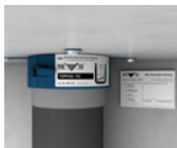
Anschrauben und Rohrabschottung mit Kennzeichnungsschild kennzeichnen.
