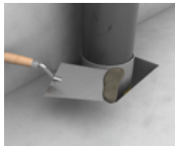
Restöffnung in Bauteildicke mit mineralischem Mörtel verschließen.
