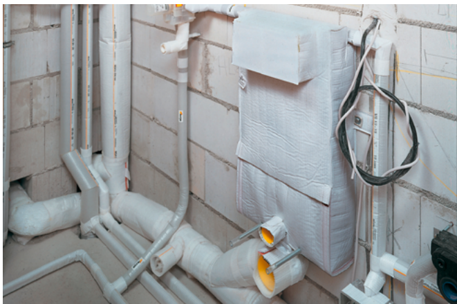
Bild 5 Dämmung von TWK mit Misselfix-Garant sowie Dämmung von weiteren Rohrleitungen und Sanitärelementen
