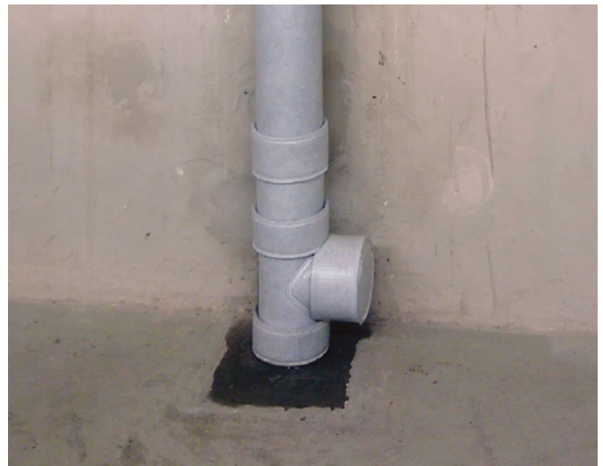
Bild 42 Das funktionssichere Gesamtsystem ist mit seinen lückenlos passgenauen Formteilen auch nachträglich am Rohr, an Muffen, Verbindern etc. installierbar.
