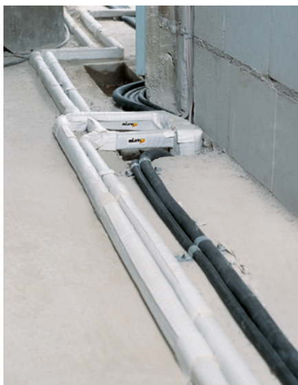
Bild 19 Rohrleitung im Fußboden (Missel Kompakt-Dämmhülle KDH 035)
