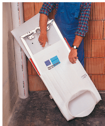
Bild 55 Einfache und schnelle Montage des Dämm-Formteils MSWC zur Körperschalldämmung von Unterputz-Spülkästen, die eingemauert werden
