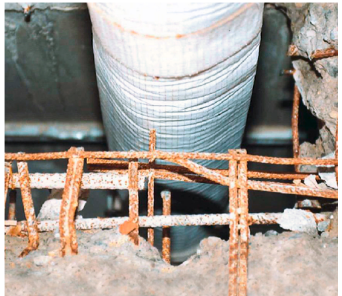
Bild 40 Die reißfesten Missel Körperschalldämmungen MSA 4 bzw. MSA 9 halten auch scharfkantigen Armierungen und Deckendurchbrüchen stand
