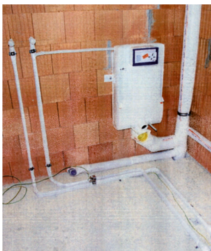
Bild 53 Spülkasten, gedämmt mit der Missel Körperschalldämmung MSWC, und mit Missel Dämmungen körperschallgedämmte Trinkwasser- und Abwasserleitungen
