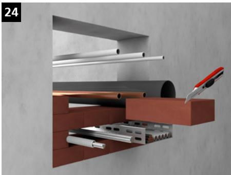
Schneiden Sie die KaRo-Steine im Bereich von Installationen entsprechend den Konturen zu, sodass sie an den Installationen anliegen.
