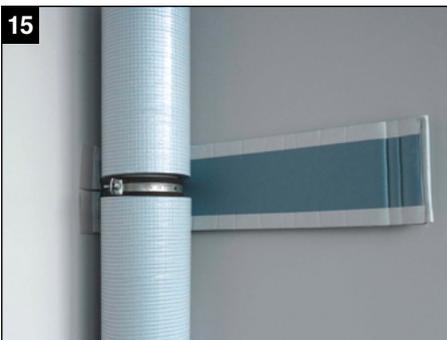
(R) Formteil Muffe auf Höhe Rohrschelle mittig positionieren
