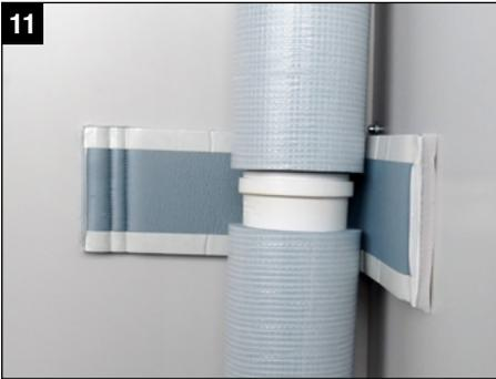
(M) Montage Streckendämmung bis an Muffe, danach Formteil für Muffe
