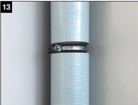
(R) Montage Streckendämmung bis an Rohrschelle
