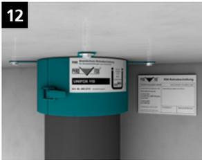
12 Abschließend Rohrabschottung mit Schild kennzeichnen.
