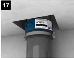
17 Manschette aufsetzen und schließen. Eine Rohrschelle zur Positionierung ist hilfreich.
