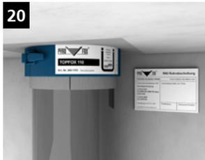
20 Abschließend Rohrabschottung mit Schild kennzeichnen.
