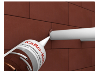
Beidseitige Verfüllung 20 mm tief
